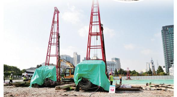
从4日起,就可以打灌注桩了。同样是从4日开始,预制桩也会进场,5日开始可以打预制桩。现在打的都是造房子本身所需的桩,过一个月,还会有另一种打桩机进场,主要在工地四周打搅拌桩,确保后续土方开挖时的安全。
