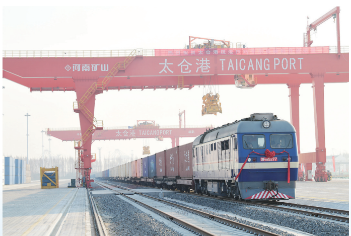
太仓港疏港铁路专用线通车
