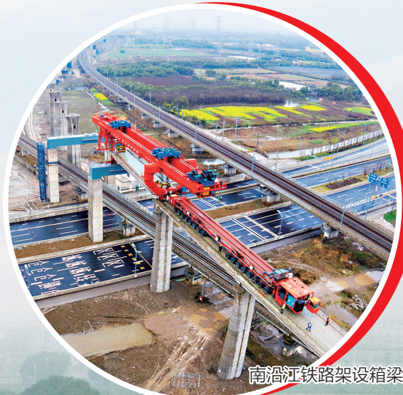
南谿江铁路架设箱梁
