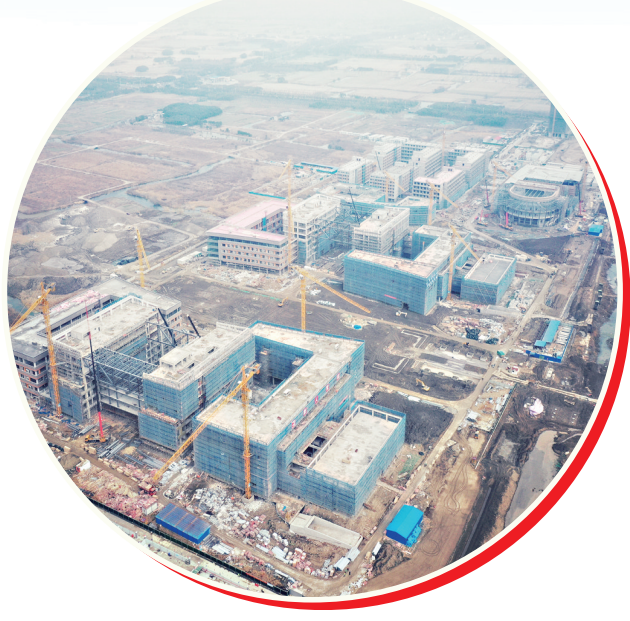
火热建设中的西北工业大学太仓校区
