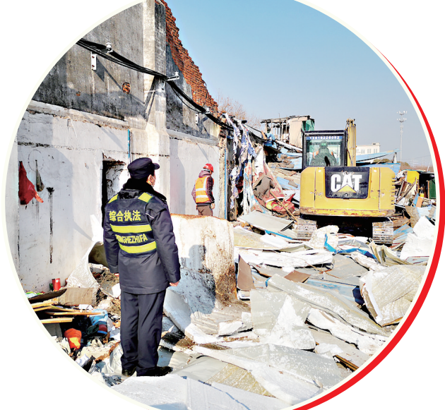
娄东街道推进板捷街拆迁
