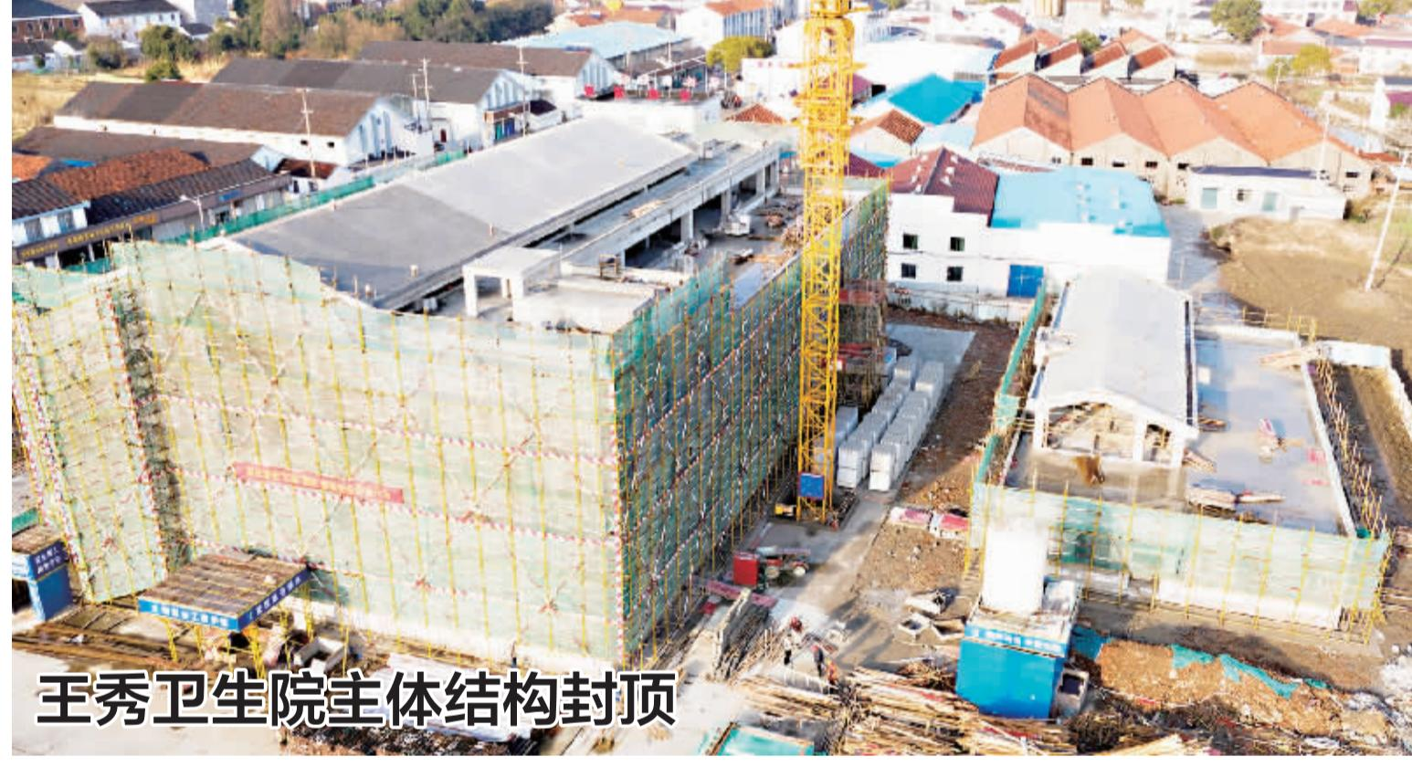
王秀卫生院新建项目工程由综合楼、后勤楼、门卫室组成,建筑面积6000多平方米。该工程去年下半年动工建设,目前已完成主体结构封顶施工。
