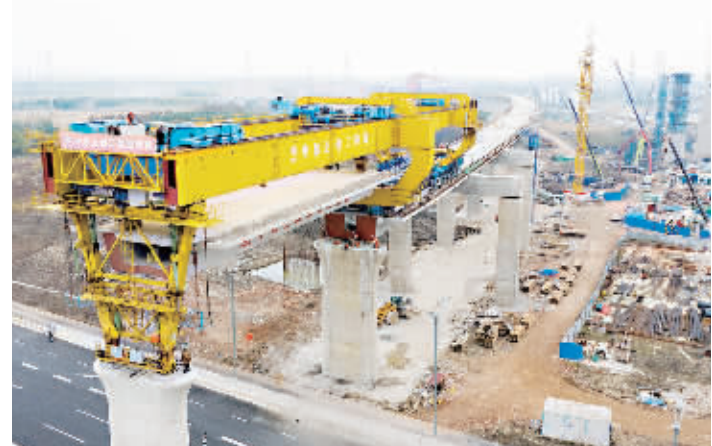
南沿江城际铁路跨浏太路箱梁架设
