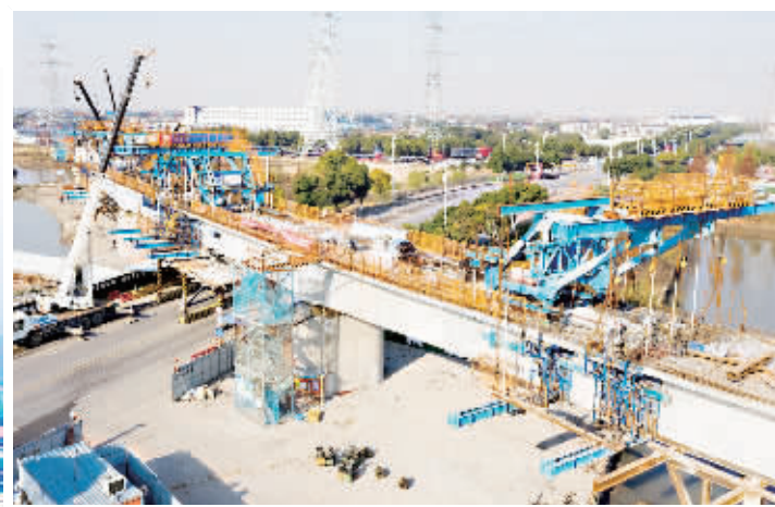
疏港铁路架梁建设
