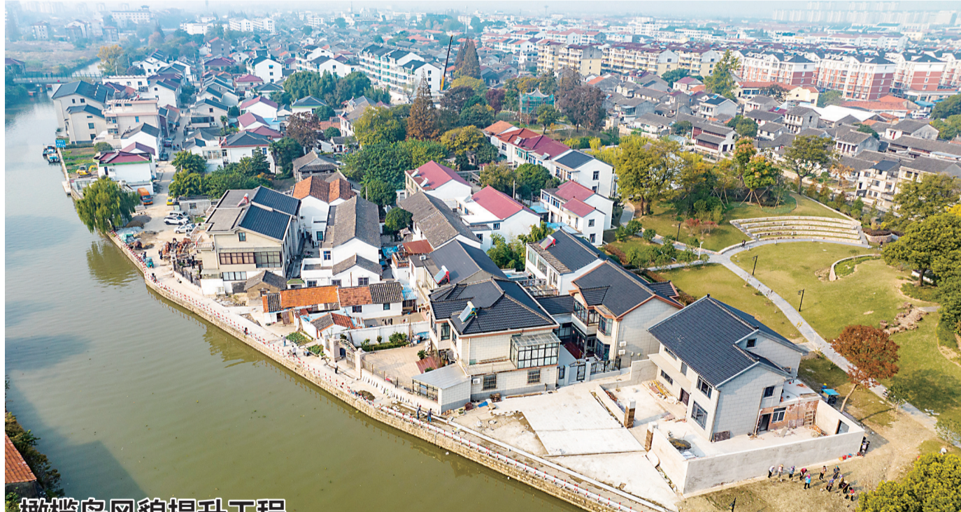
橄榄岛风貌提升工程
