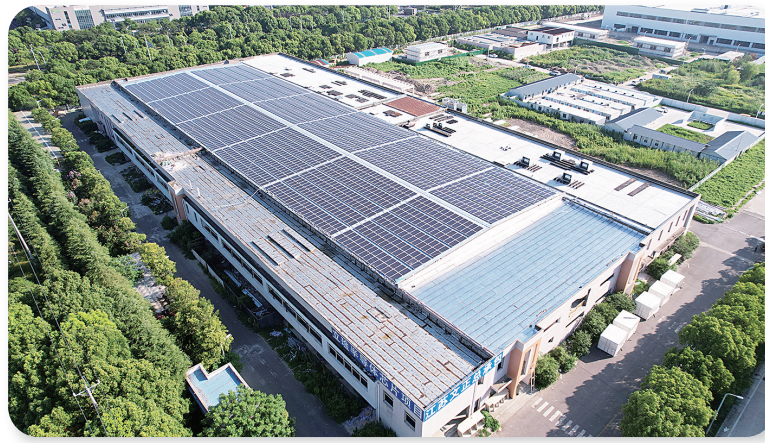
立矽半导体芯片项目加速推进
